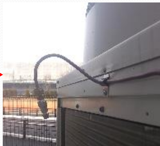
再生水を室外機に噴霧する噴霧機・夏季の節電効果
